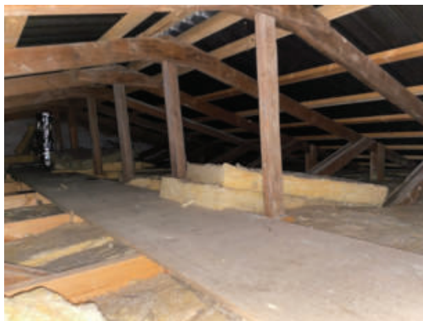
Rodet isolering på loft
