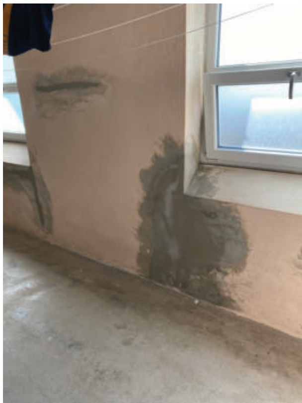
Udbedret revner i kælderydervæg
