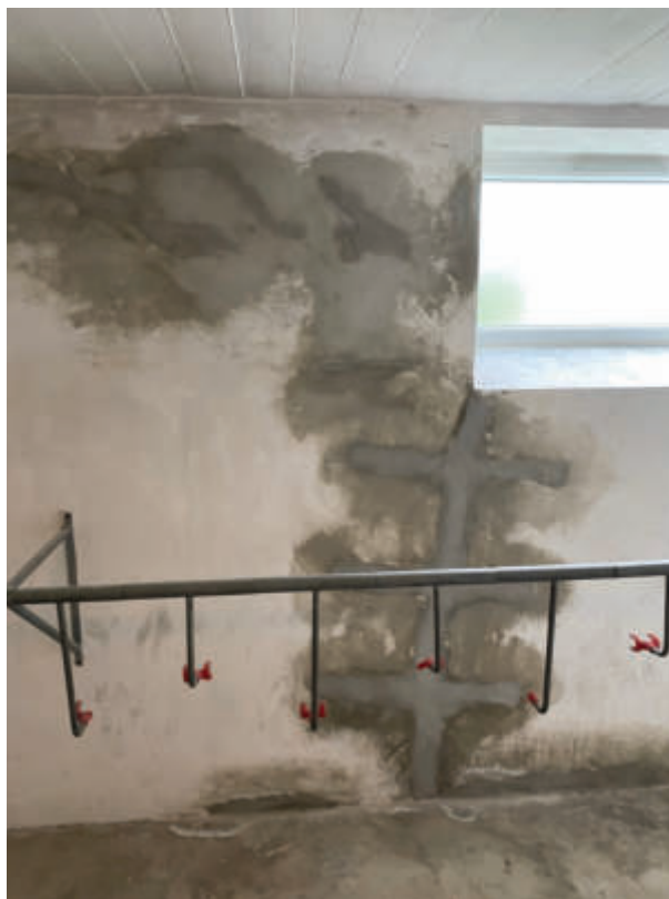
Udbedret og armeret revne i kælderydervæg
