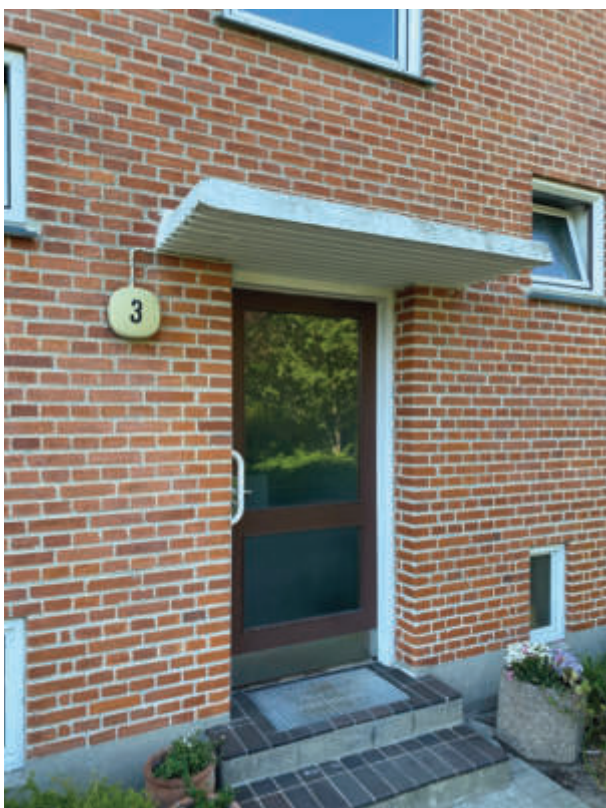
Overdækning i malet beton Blok A
