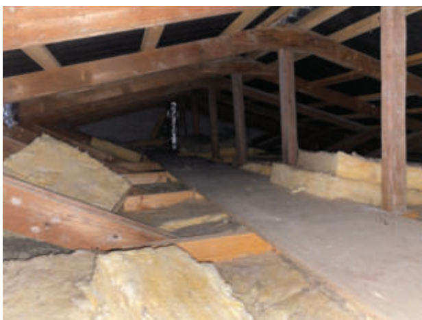
Rodet isolering på loft
