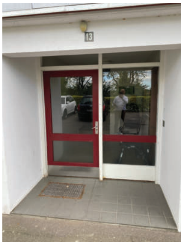
Dørparti til opgang i Blok B
