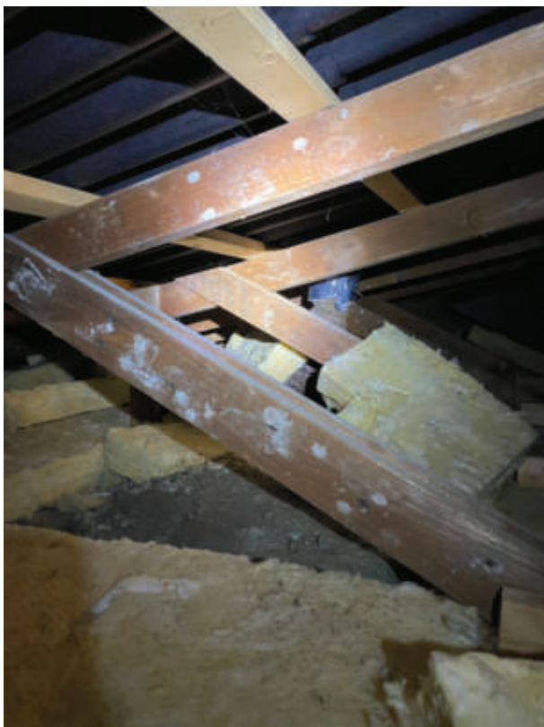
Rodet isolering på loft
