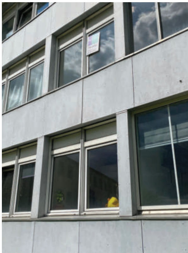
Altan Blok B
