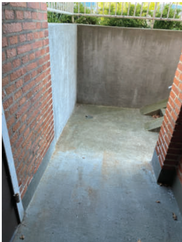
Kældertrappe og gulv Blok A
