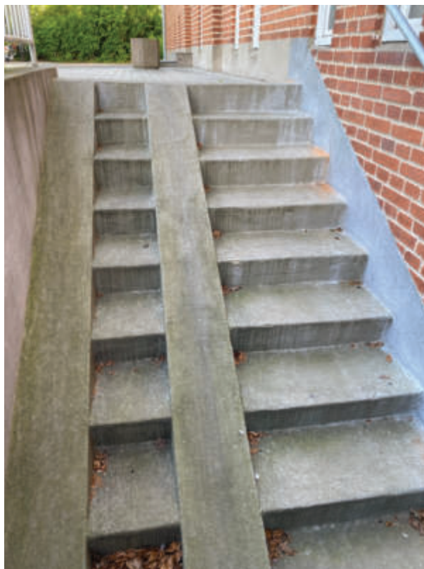
Kældertrappe Blok A
