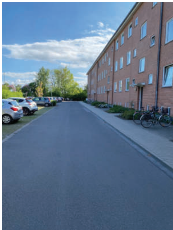
Asfalt foran blok A
